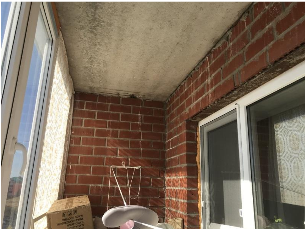
Фото №42. Правая сторона лоджии кв. №27. Сплошные ряды ложковой кладки.
