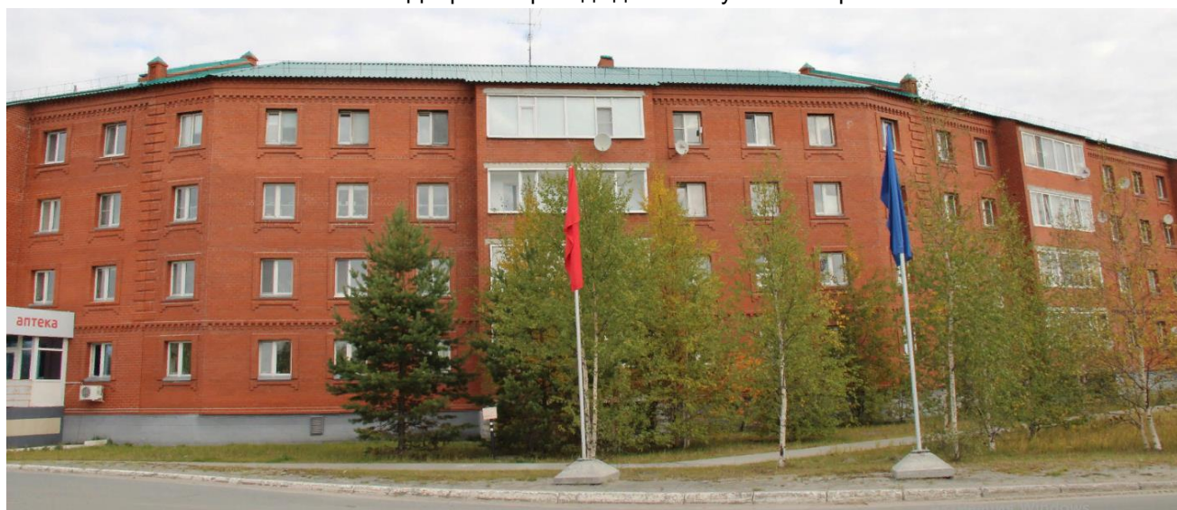
Фото №5. Вид на поворотную секцию дома №28 с ул. Магистральная .
