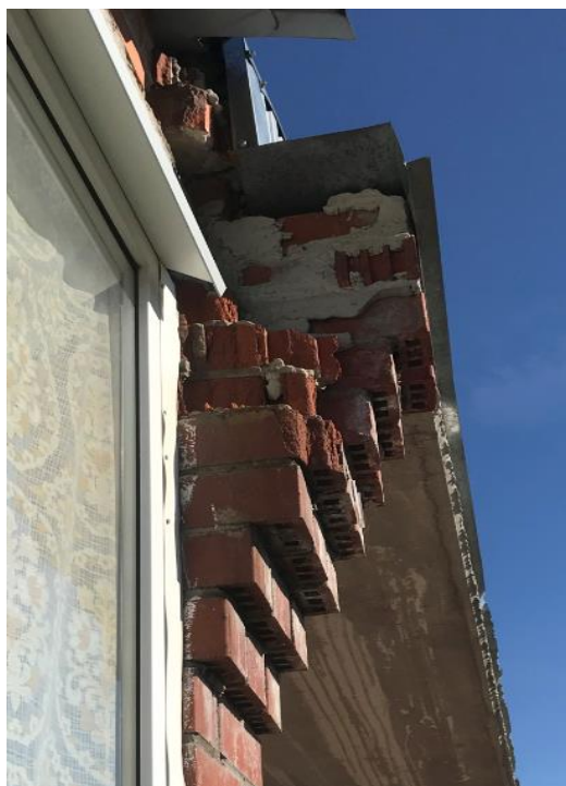
Фото №42. Правая сторона лоджии кв. №27. Сплошные ряды ложковой кладки.
