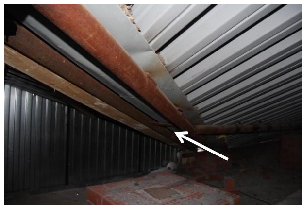
Фото №21. Отсутствие связей и снег ( из результатов обследования в феврале 2022г.)
