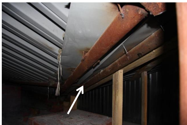
Фото №21. Отсутствие связей и снег ( из результатов обследования в феврале 2022г.)
