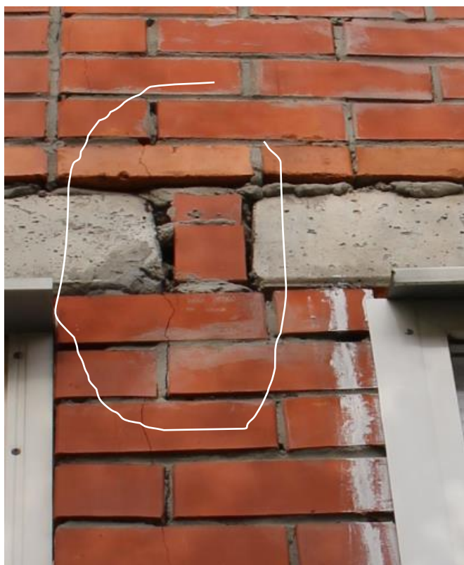
Фото №37,38 Ул. Магистральная 24/1. Трещина по кладке.
