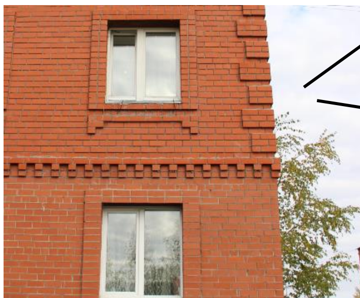
Фото №18,19. Несоблюдение требований проекта- однорядная перевязка облицовки фасада дома №28 вместо трехрядной, при надписи производителя работ «работы выполнены по чертежам».
