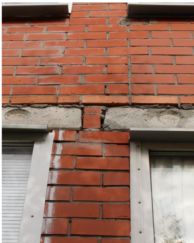
Фото №37,38 Ул. Магистральная 24/1. Трещина по кладке.
